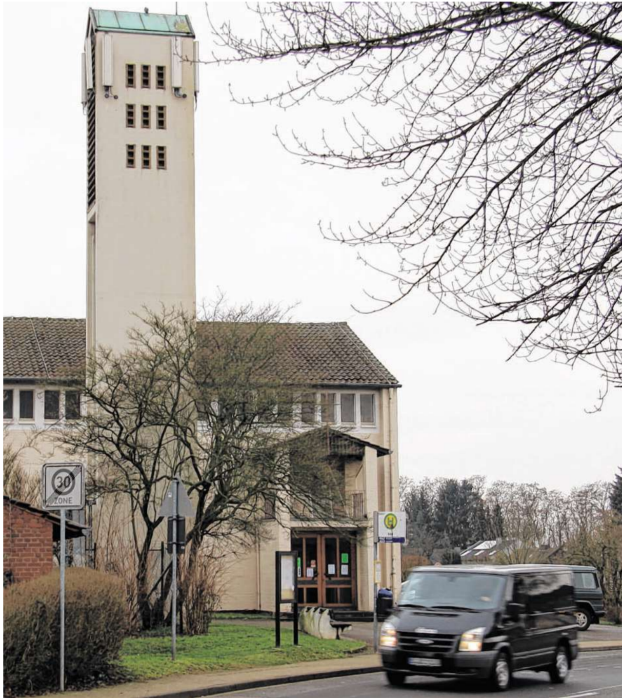
Vor dem Umbau: Der Innenraum der Paul-Gerhardt-Kirche in Ofden (Bild) wird zur Erweiterung des angrenzenden Kindergartens verkleinert. Foto: Karl Stüber
