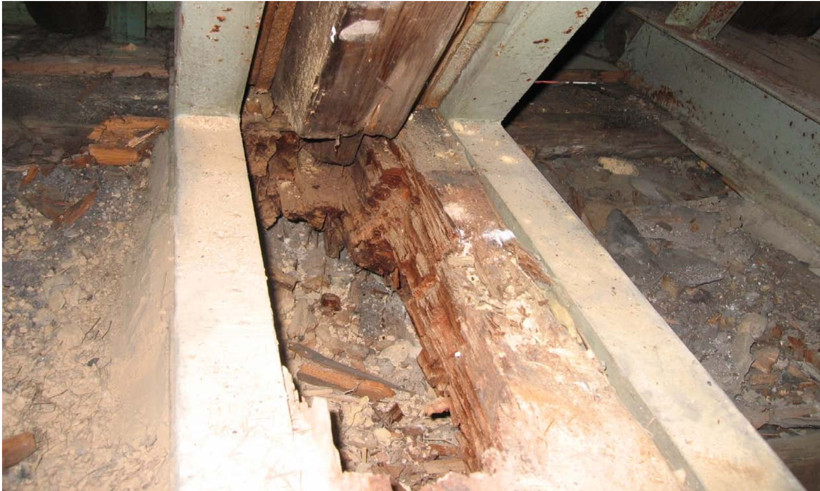
Balkenkopf und Sparrenfuß, Echter Hausschwamm
