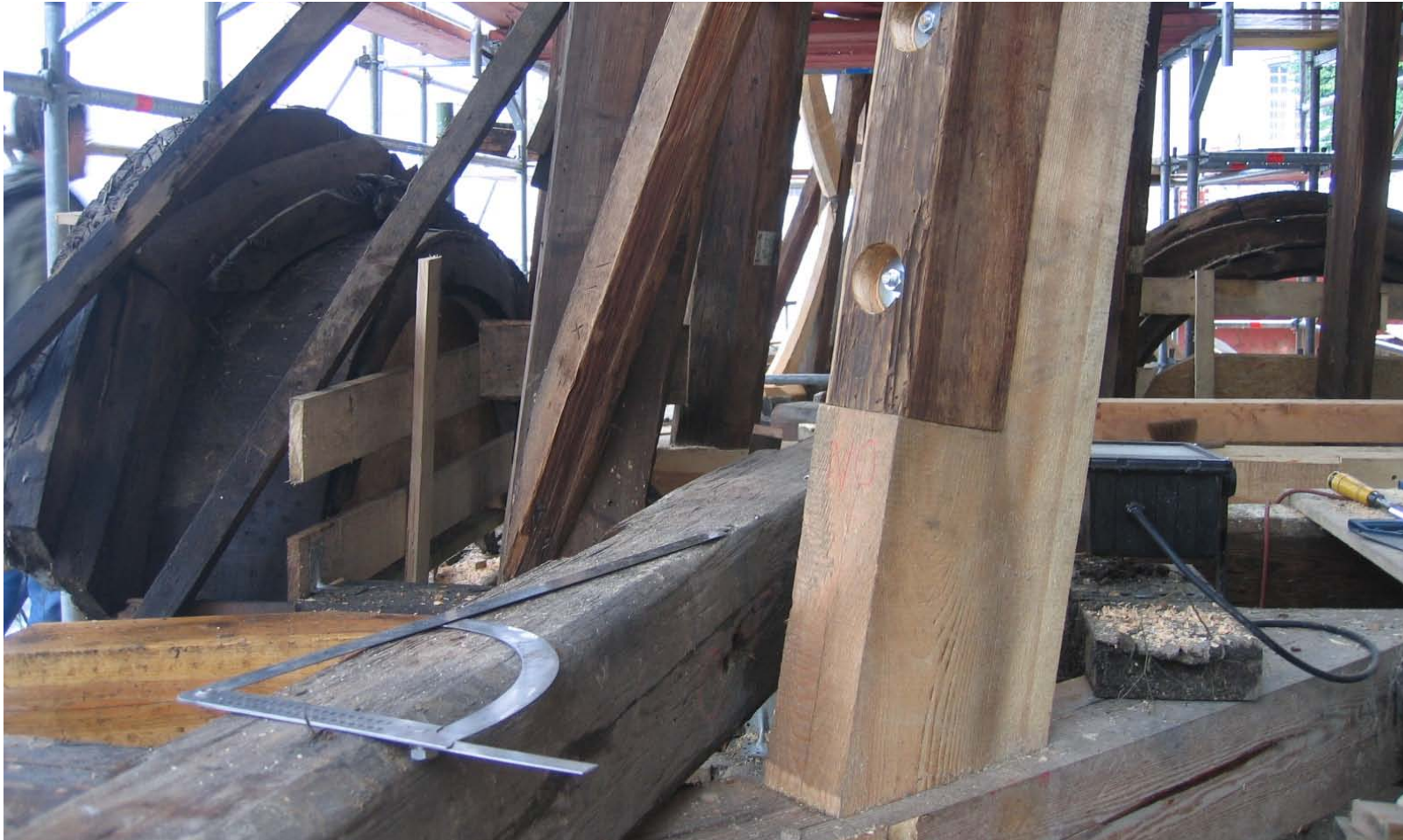
Turmhaube, Ebene 1, Balkenstern und Stuhlsäulenfuß
