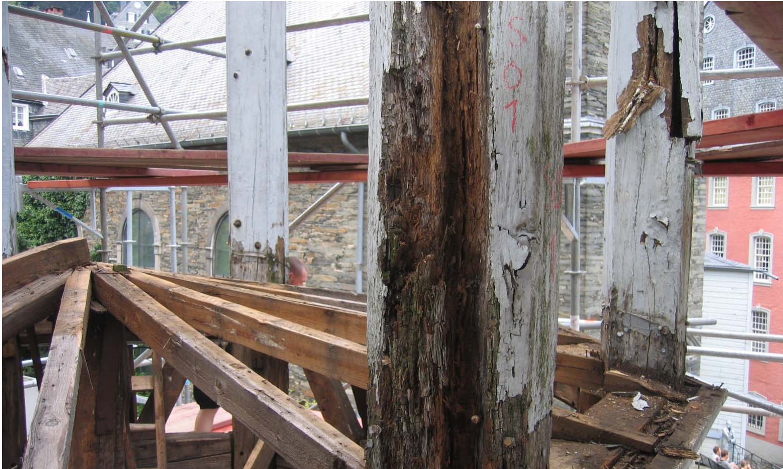
Bau begleitende Begutachtung, Laternenständer
