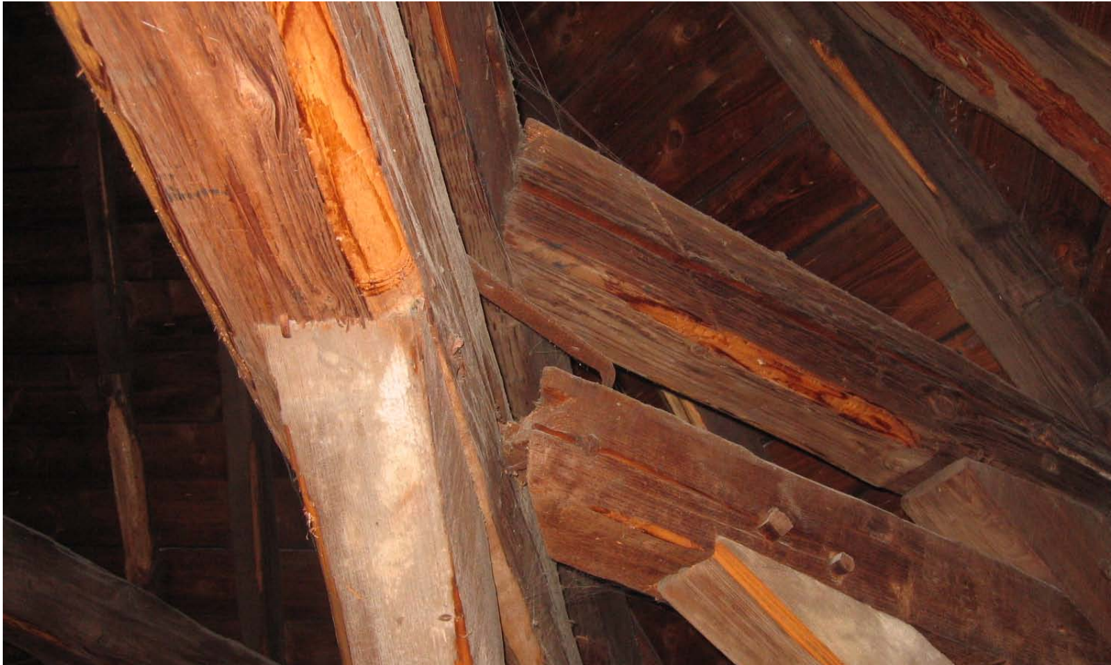
obere Dachkonstruktion, offene Holzverbindungen
