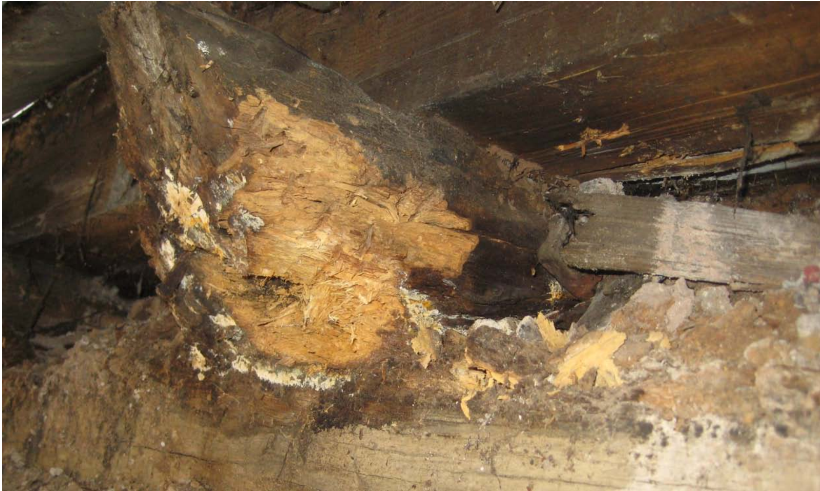
Ausgebreiteter Hausporling → Fäuletyp Weißfäule
