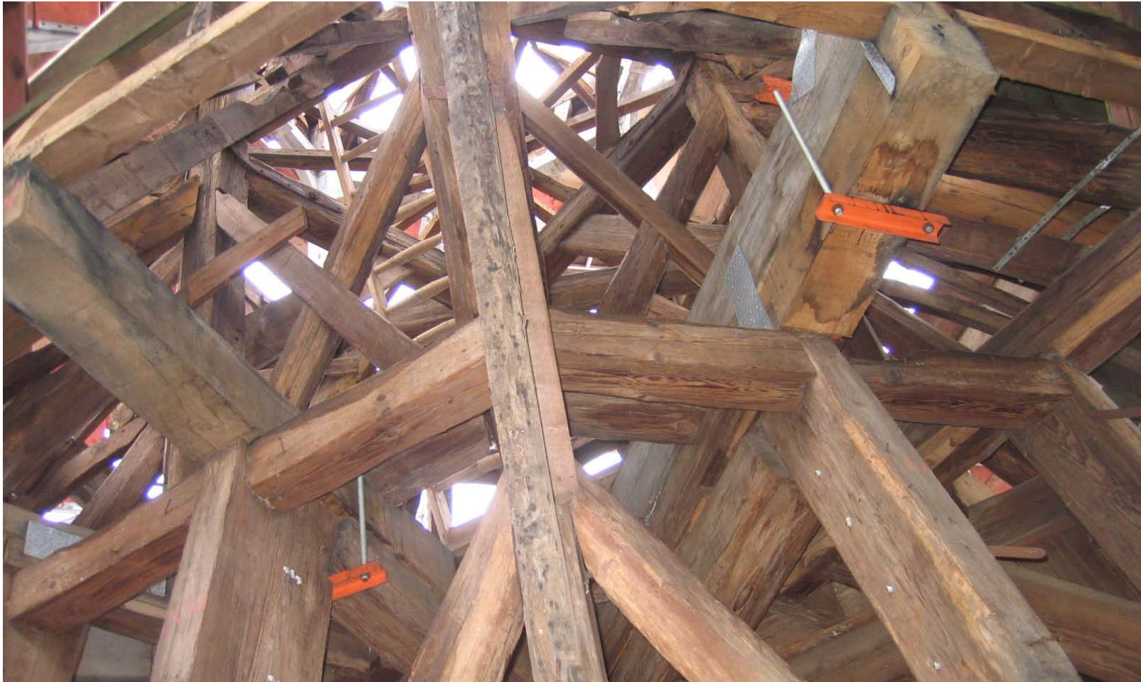
Bau begleitende Begutachtung, Turmhaube
