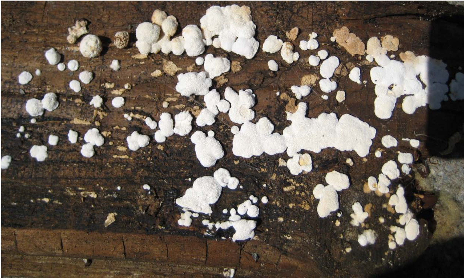
Weißer Porenschwamm + Brauner Keller- oder Warzenschwamm → Braunfäule
