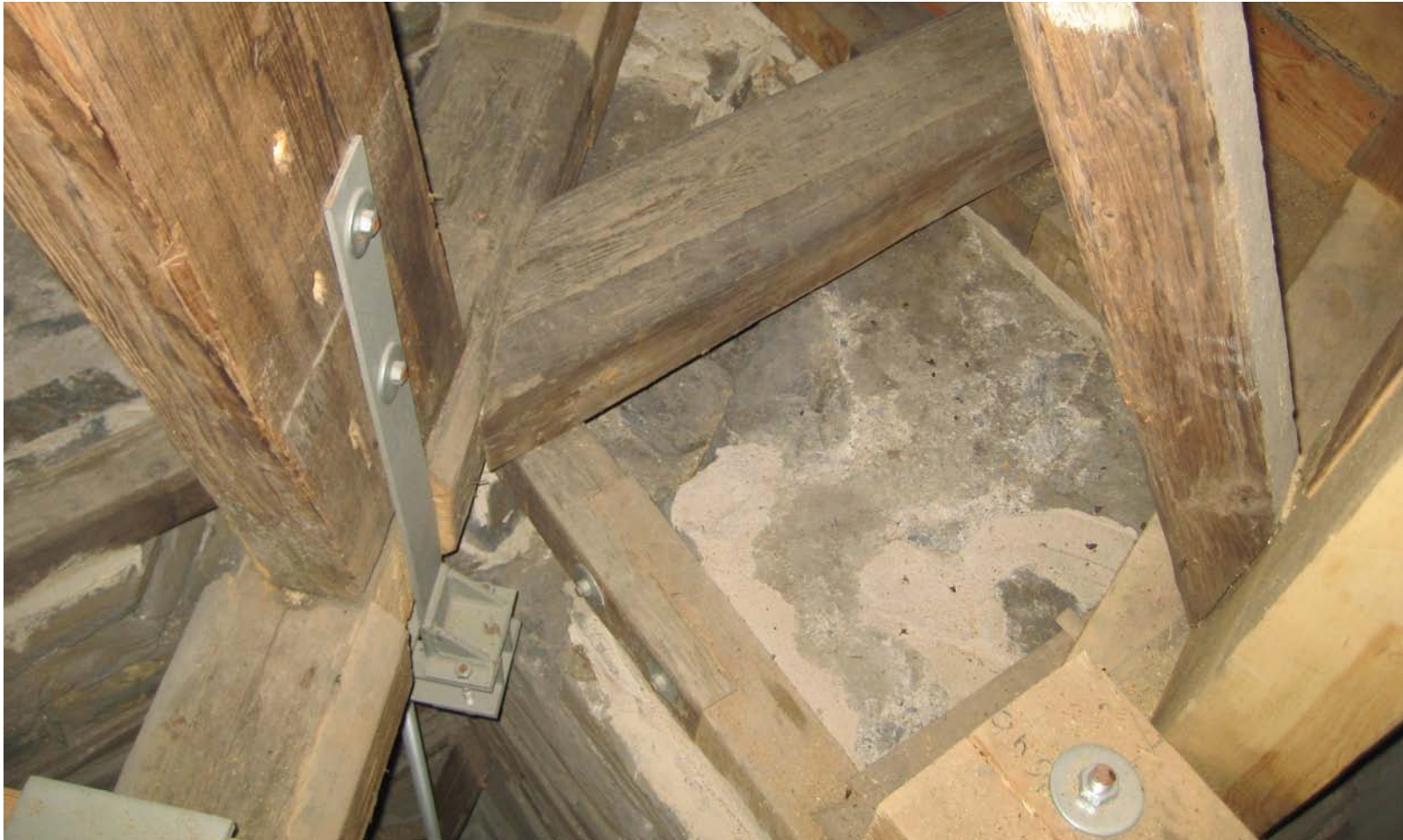
Turmhaube, Mauerkrone, Auflager
