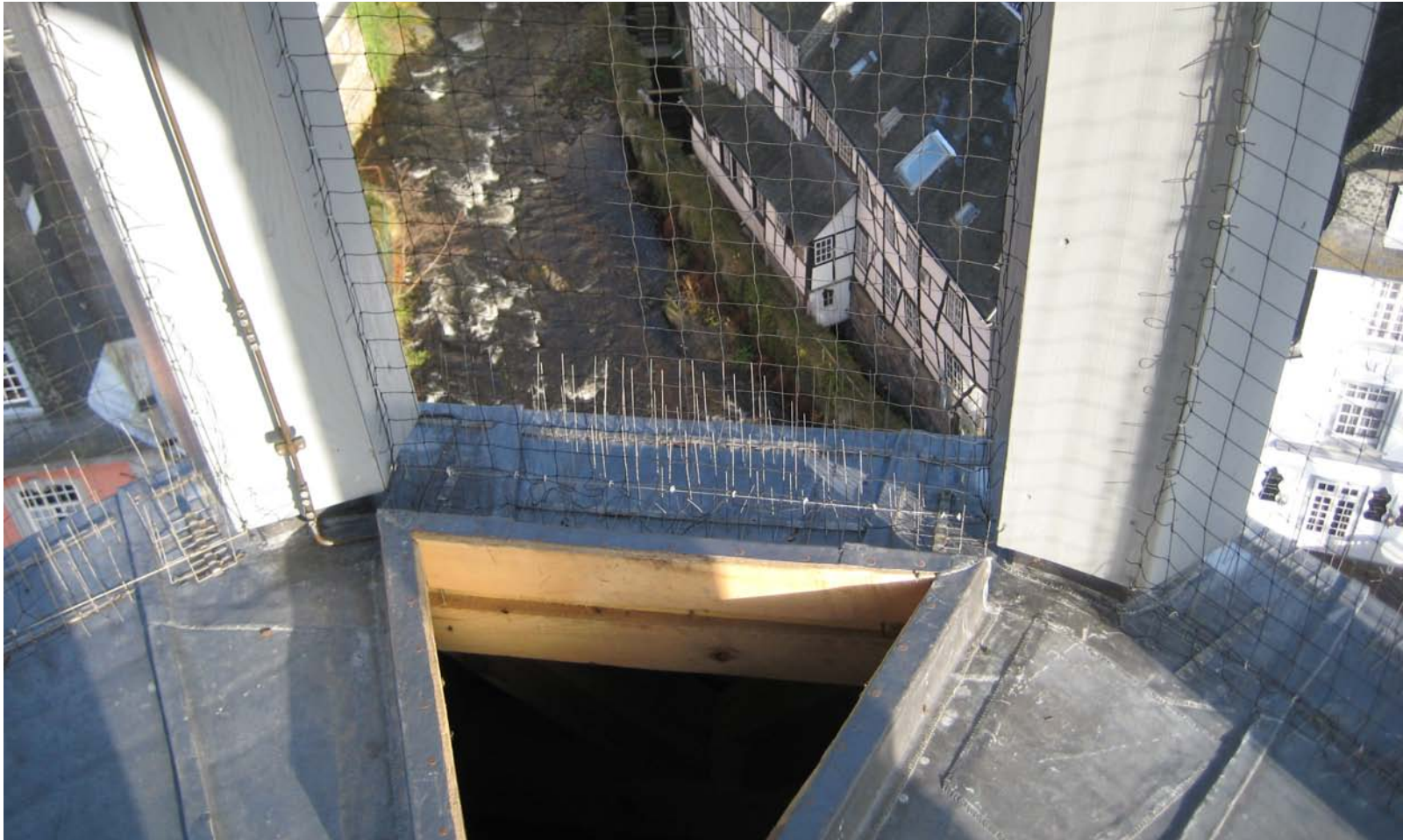
Laternenboden, Ausstieg, Laternenständer baulicher Holzschutz beachtet
