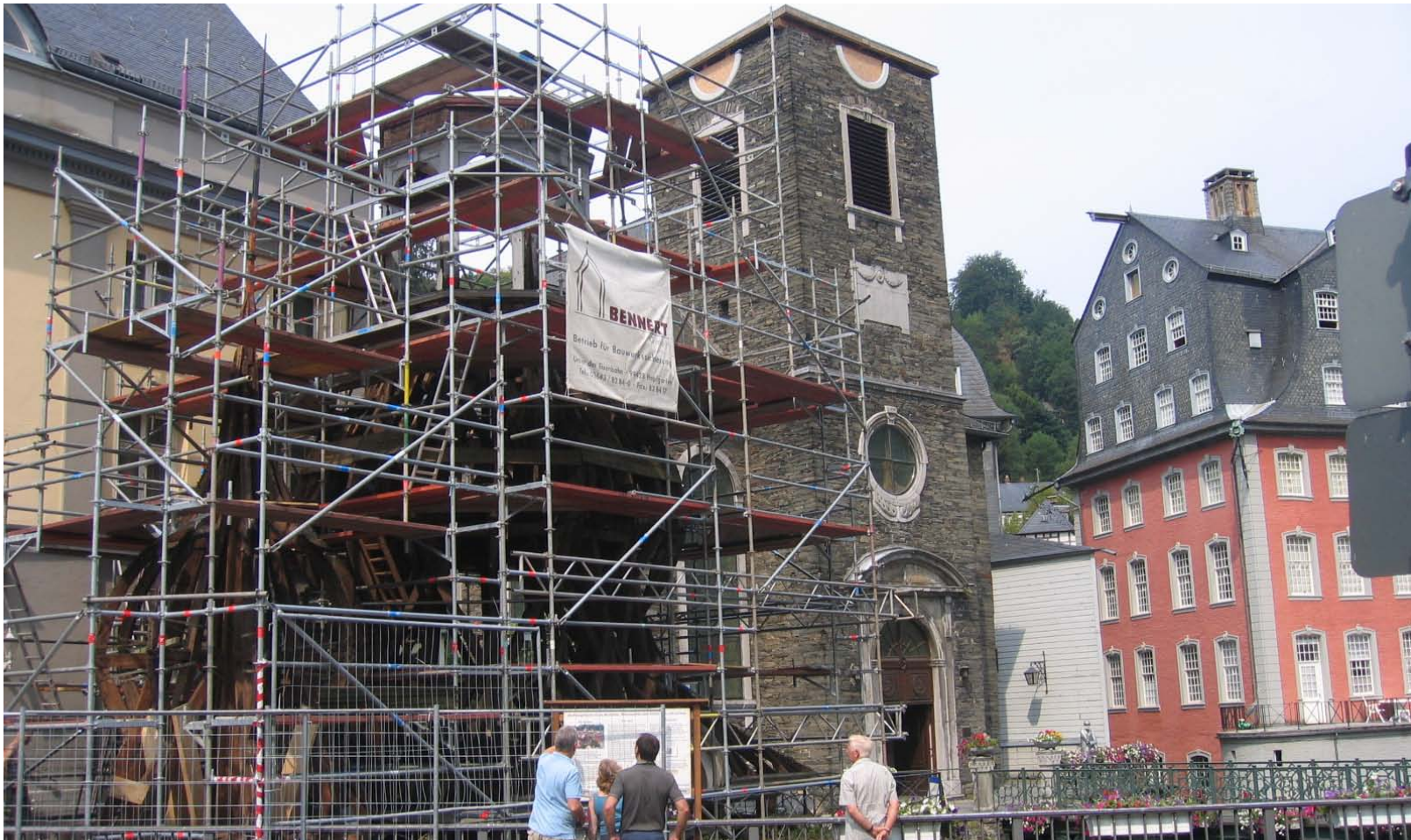
Demontage von Turmhaube, Laterne und Helm
