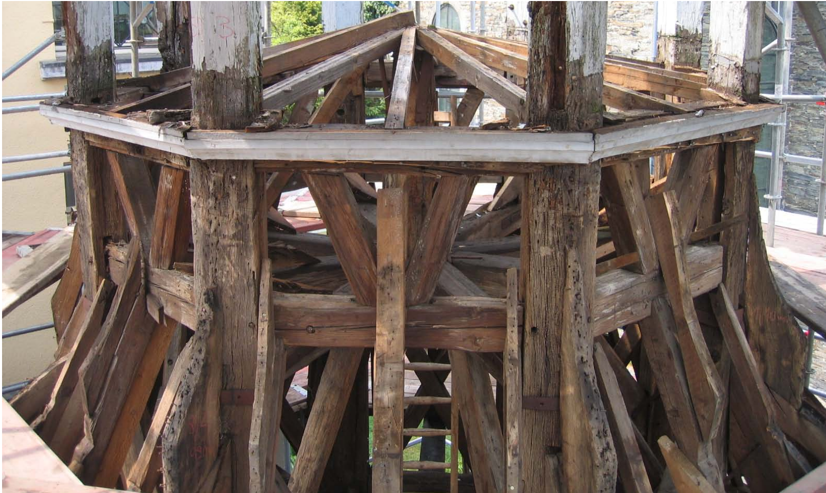
Bau begleitende Begutachtung, Turmhaube
